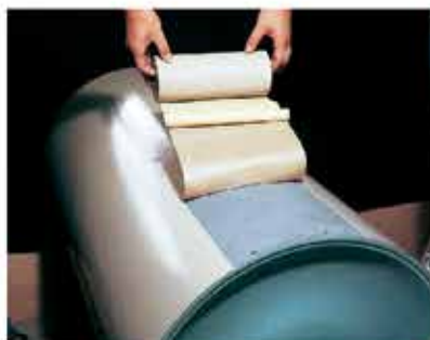
ロールライニング施工
