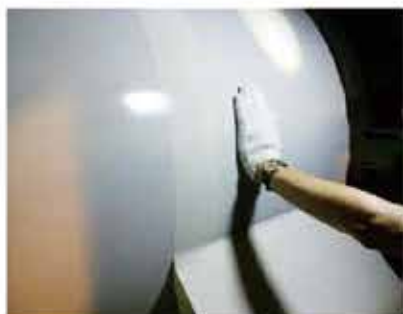
ロールライニング施工
